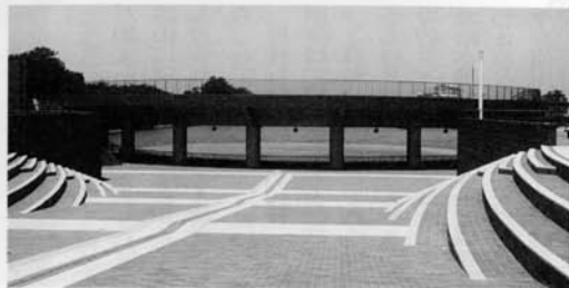
野外劇場風の広場と湧泉で構成されるフロントデッキ。 (富岩運河環水公園)
