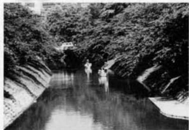
松川はかつての神通川湾曲部分の名残り
